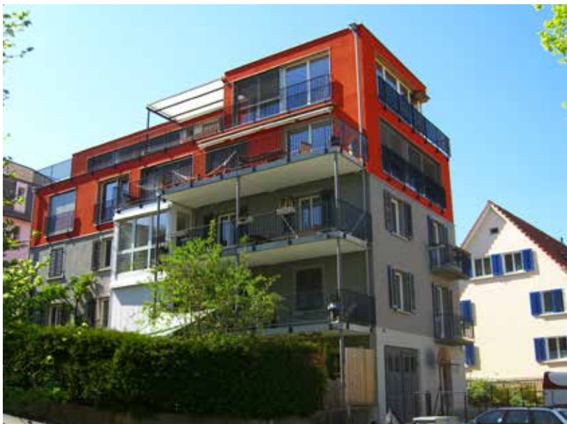
Diese Aufstockung in Thalwil zeigt wie Bestehendes weiterentwickelt werden kann. Quelle: RZU
